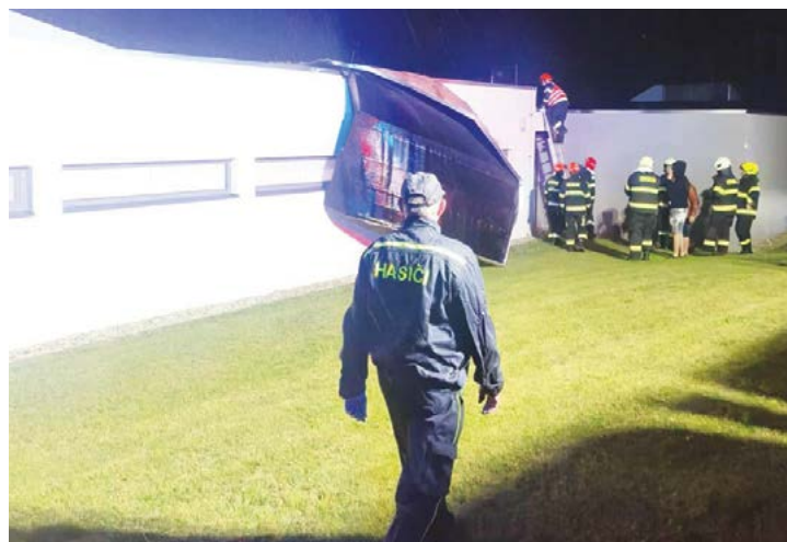
Zásah u utržené střechy
